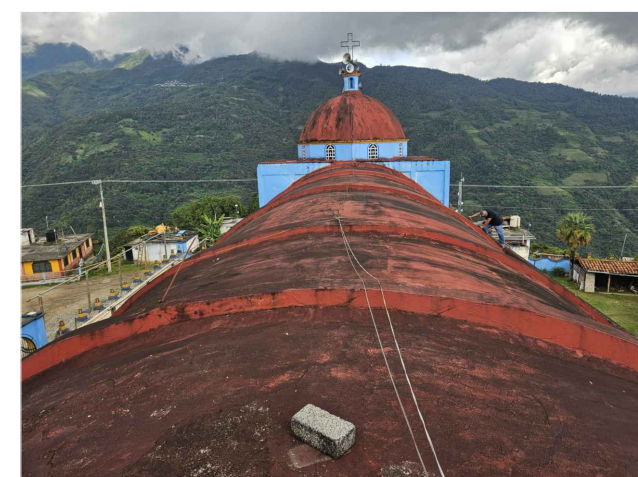
FOTO 07 - EXTRADOS DE BÓVEDA DE CAÑÓN CORRIDO DE NAVE, AL FONDO TAMBOR Y CÚPULA DE PRESBITERIO.
