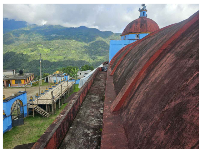
FOTO 08 - EXTRADOS DE BÓVEDA DE CAÑÓN CORRIDO DE NAVE, AL FONDO TAMBOR Y CÚPULA DE PRESBITERIO.
