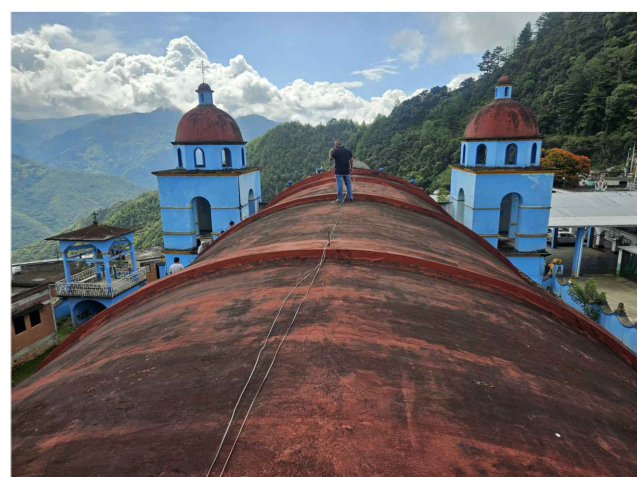
FOTO 06 - EXTRADOS DE BÓVEDA DE CAÑÓN CORRIDO DE NAVE, AL FONDO CAMPANARIOS NORTE Y SUR.
